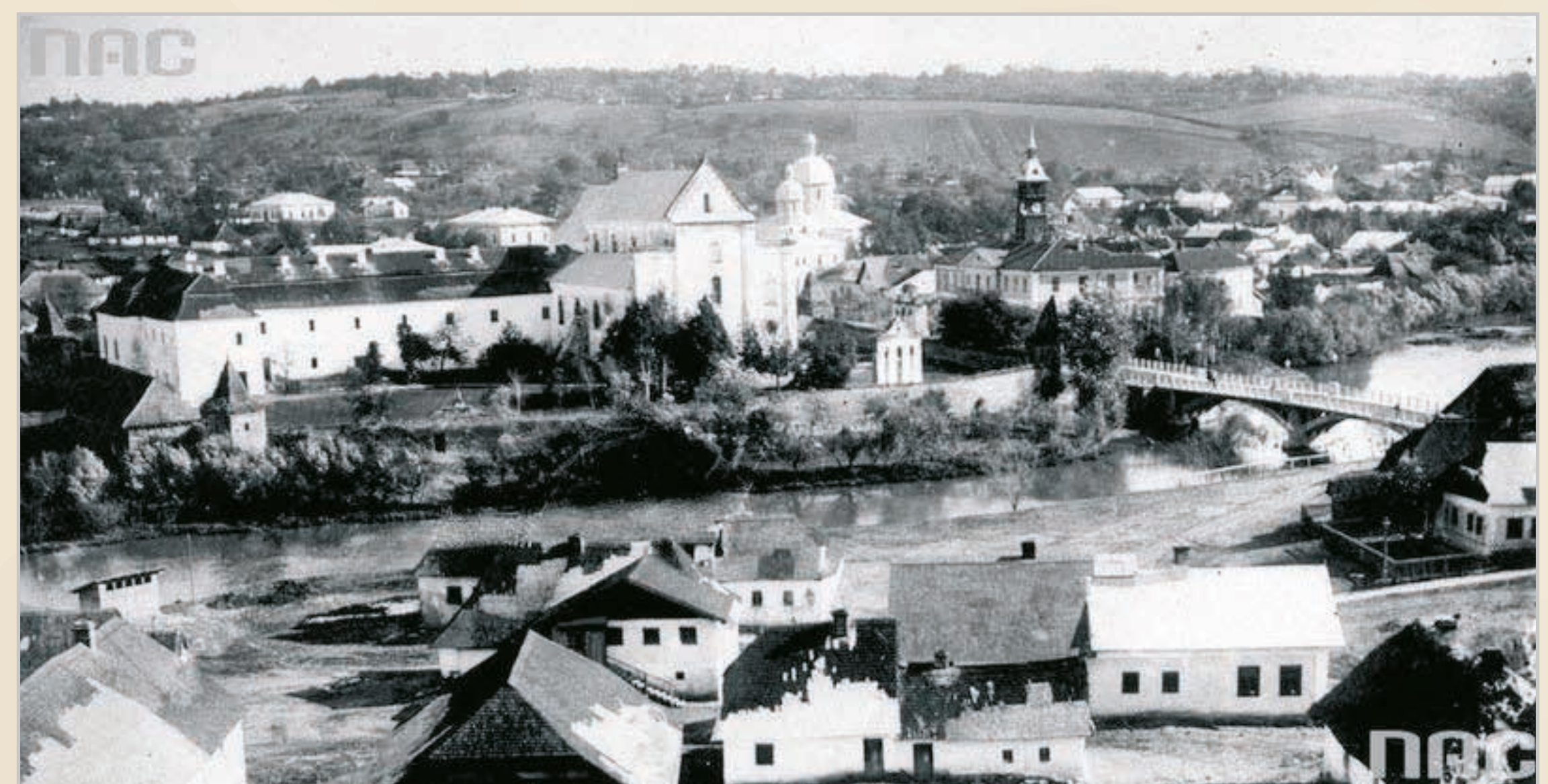
Trembowla, lata 20. XX w., widok miejscowości, po prawej stronie widoczny most na rzece Gniezna. Zbiory NAC, sygn. 1-U-6413.
