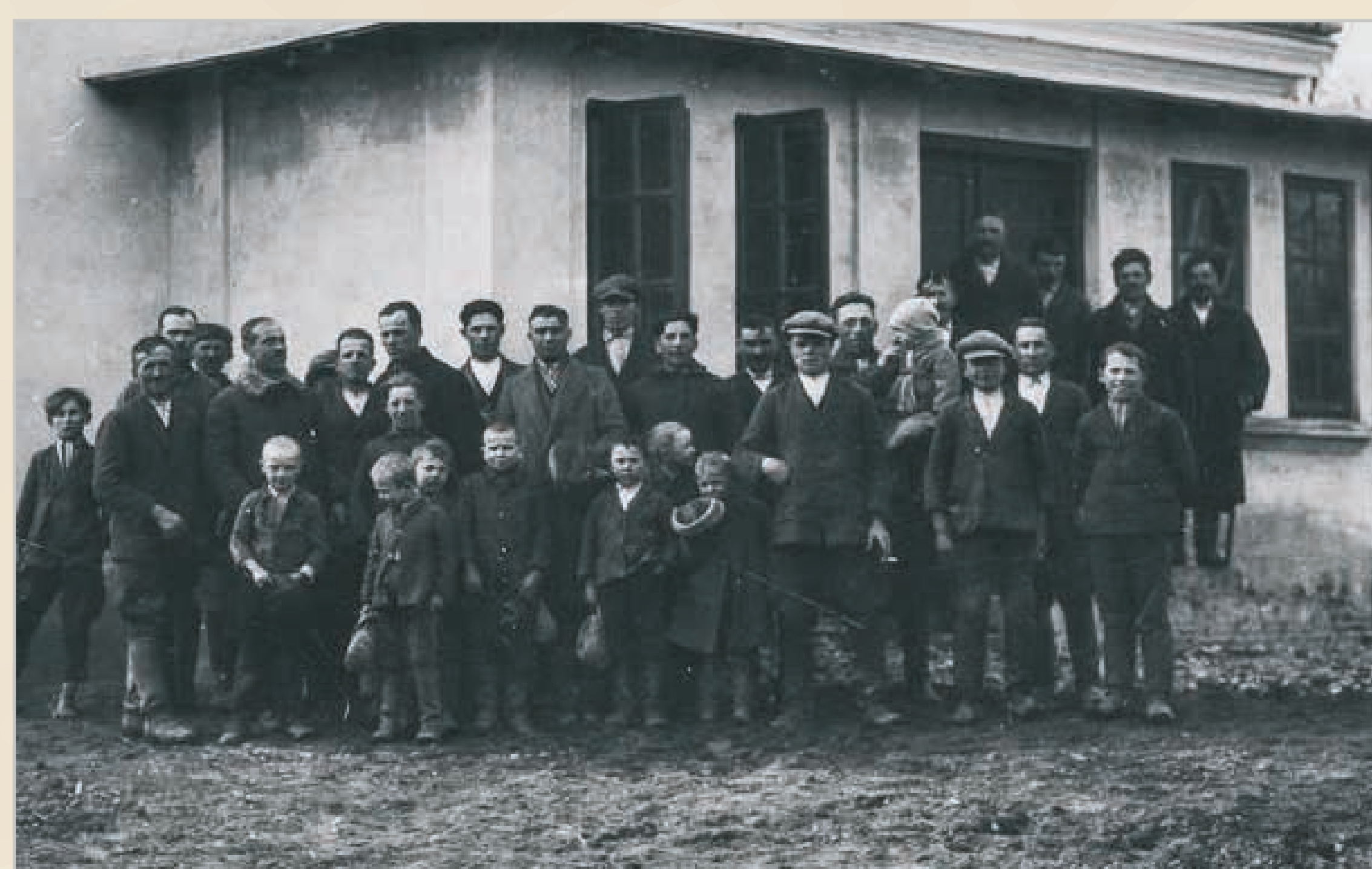
Romanówka k. Tarnopola widok domu TSL. Zbiory NAC, domena publiczna, dostęp 22.07.2023.
