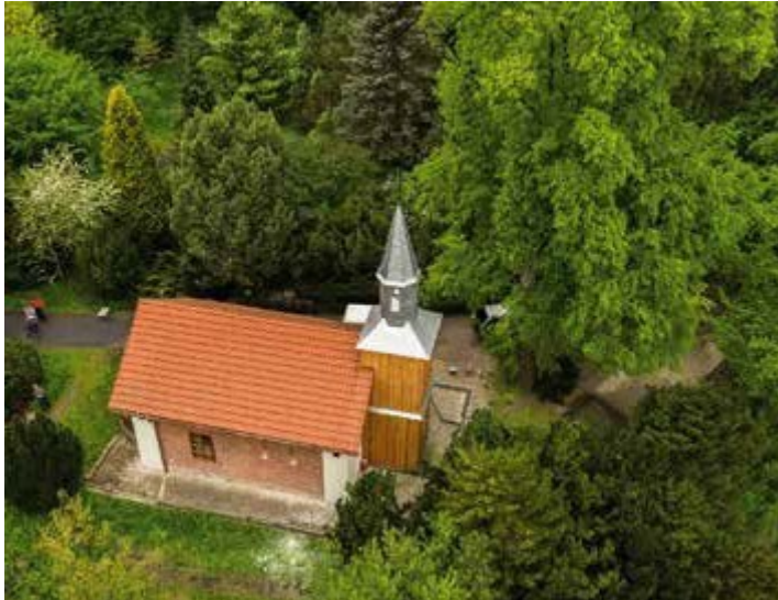
Ryc. 11. Kaplica – widok z lotu ptaka, 2015, fot. M. Horwat
