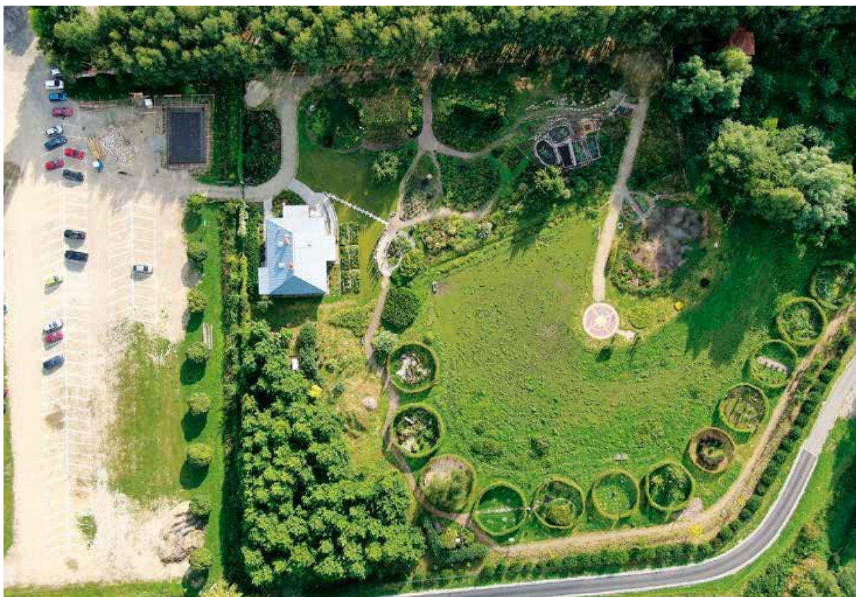
Ryc. 69. Dom z Jodłówki, pawilon wejściowy w trakcie budowy i nowo zagospodarowany teren na Niwie Dolnej – widok z lotu ptaka, 2020, fot. Ł. Malicki
