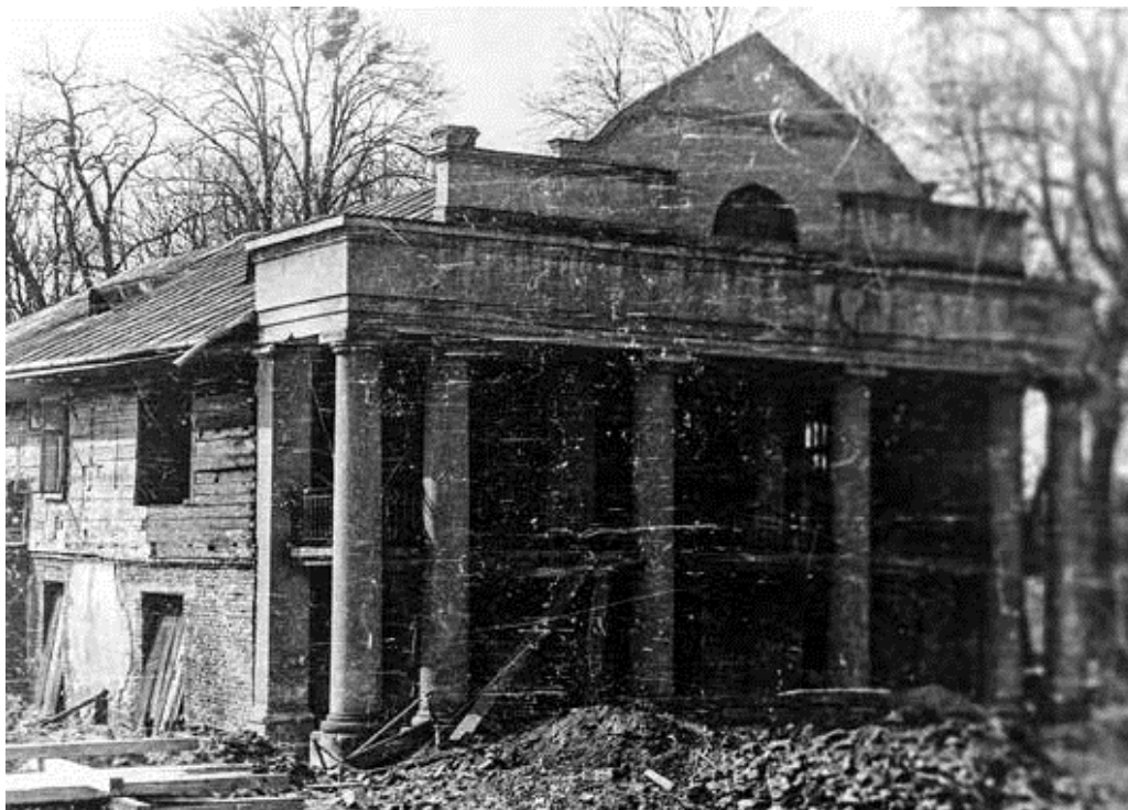
Ryc. 14. Dwór, elewacja szczytowa północna i fragment elewacji wschodniej, lata 70. XX w., fot. ze zbiorów Arboretum Bolestraszyce
