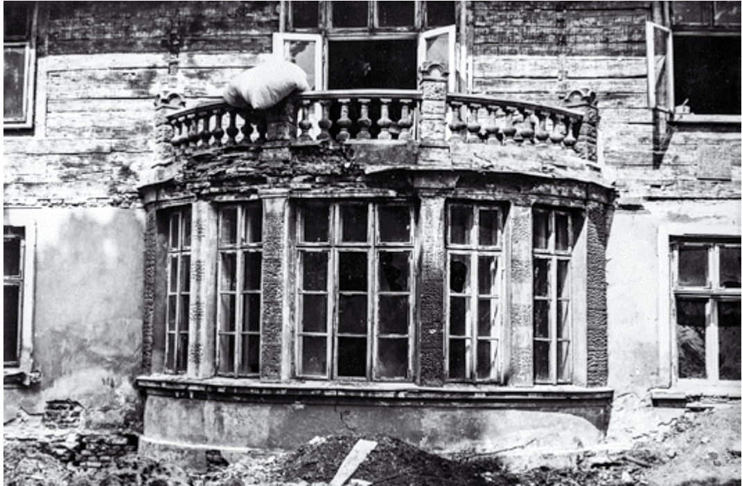
Ryc. 17. Dwór, elewacja południowa przed remontem, 1975, fot. ze zbiorów Arboretum Bolestraszyce i fragment elewacji południowej, 1975, fot. A. Krzak (po prawej)
