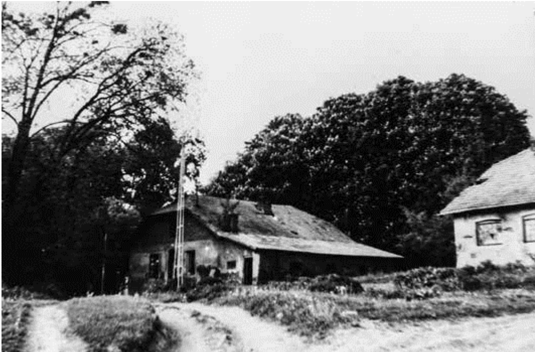
Ryc. 20. Zniszczony budynek mieszkalno-gospodarczy z drugiej połowy XX w., usytuowany pomiędzy dworem a stajnią, rozebrany w latach 70. XX w., fot. ze zbiorów Arboretum Bolestraszyce
