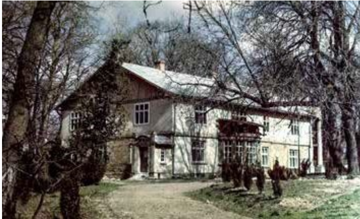
Ryc. 26. Dwór w stanie surowym po rewaloryzacji, tj. bez wykończenia wnętrza i otynkowania elewacji, lata 80. XX w., fot. Z. Mikołajczyk
