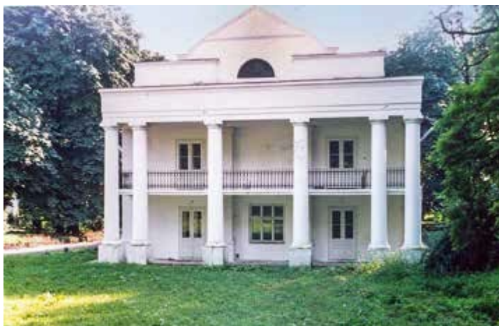
Ryc. 29. Dwór – elewacja szczytowa północna po odbudowie, początek lat 90. XX w., fot. J. Piórecki
